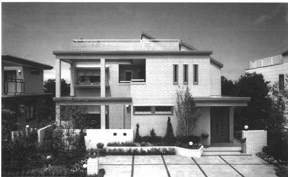
旭化成工業が提供する商品「ヘーベルハウス」は60年耐用のロングライフ住宅。今回取り上げた50年点検システムというサービス面だけでなく、商品そのもののハードとしての信頼性ももちろん高い
