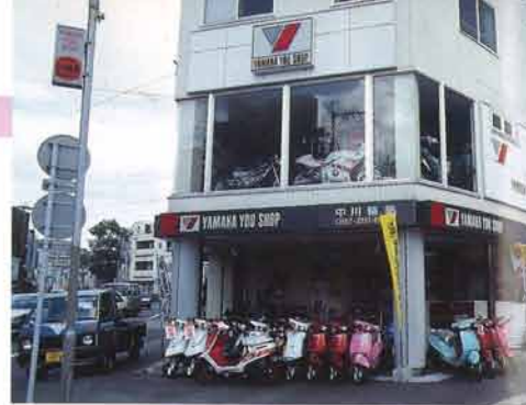
15坪の敷地に建つ4階建の新店舗。店舗の前の街灯にはお店の電飾看板が
