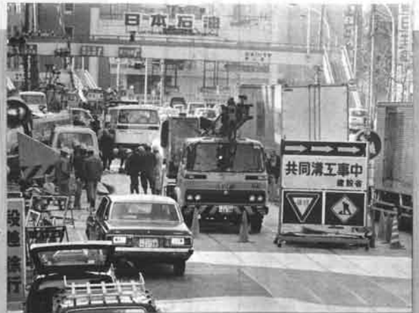
↑それだけでなく混雑する建設現場で大活躍しているのがソフトバイク
