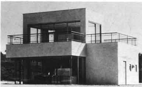
カートレースコース・コントロールタワー
