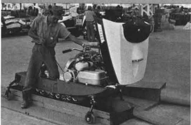
入念に完成車のテスト。スターターワイヤーのひと引きで、350 ccのエンジンがうなる。
