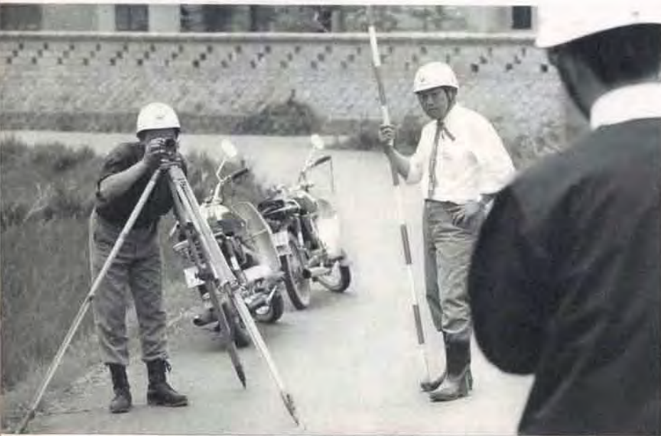
ここの沈下率はどうだ トランシットで被害状況を調べていく 現在までに道路 水道などへの被害件数は100件 損害は700万円
