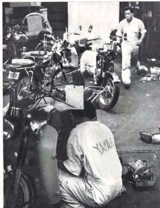
かくて冠水車は次々と分解され 洗滌され 再び組み立てられていく
