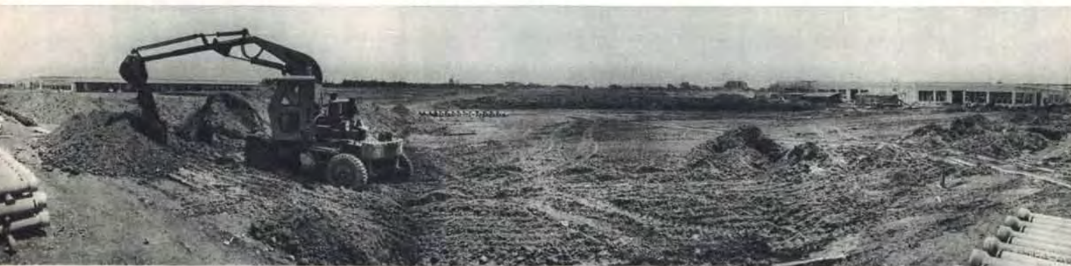
磐田新工場の建設は急ピッチですんでいる。巨大な新工場が動きはじめるのも間もなくだ。
