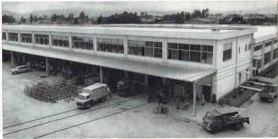
ヤマハの工場集団や協力工場から、新工場に部品が送り込まれてくる。部品は、いったんプラットフォームにおろされてから、部品管理部門に回わされる。
