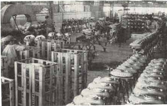
ココンバアライン・システムで生産された船外機
