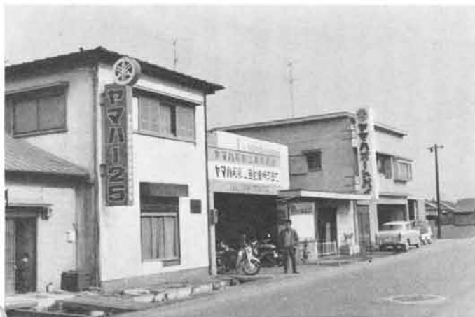
ヤマハ和歌山自動車KK本社全景
