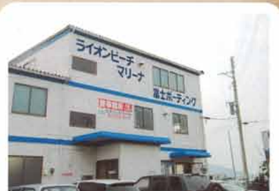
富士ボートینگ (静岡県沼津市)
