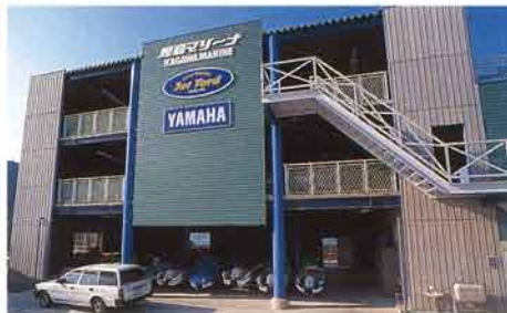
建物は3階建てで全てのフロアに保管スペースを備える
