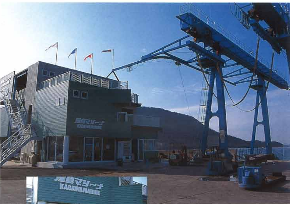
昨年の夏に完成した「ジェットヤード」の全景。従来からあったクレーンに隣接し、そのクレーンを使って各フロアから直接MJを海上に降ろすことが可能だ
