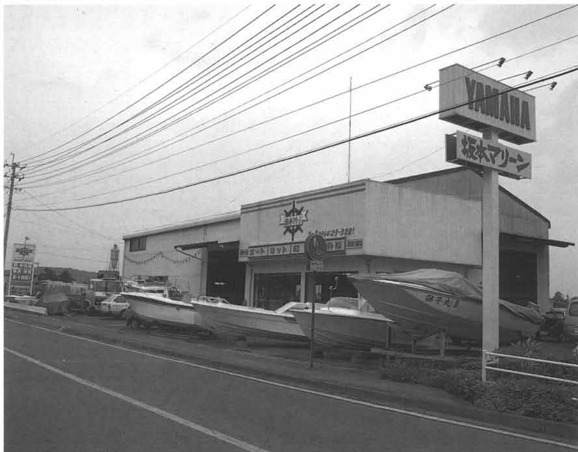
国道57号線に面してある「坂本マリン」さんの新店舗。工場の外壁には大きな看板がかけられています。
