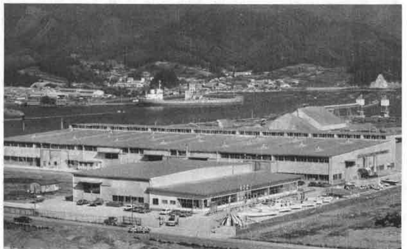
おだやかな大船渡湾をバックに建設されたヤマハ大船渡製造(株)新工場。
