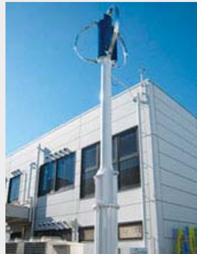
プロペラ型に比べ、静粛性に優れた縦型 風力発電システム(中瀬工場)
