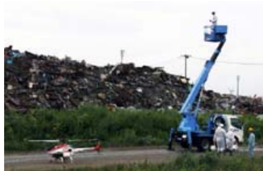
オペレーターはクレーン車から操縦
