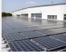
日本 袋井工場 太陽光60kw
