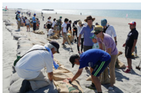
砂の入った麻袋で砂の飛散を防ぎます
