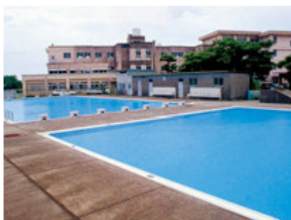
1978年設置（静岡県磐田市立東部小学校）
