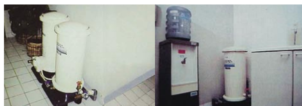
図3 マンションでの設置
