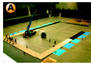
プレハブ基礎の搬入と設置
