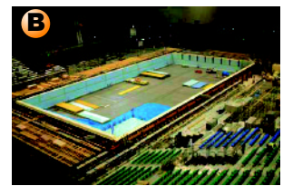
FRP本体の組み立て
