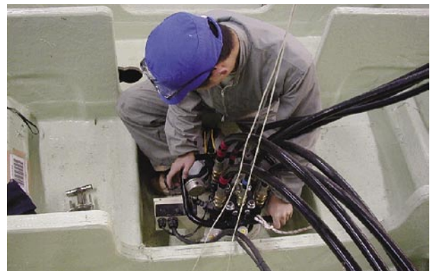
図20 ウレタン注入作業
