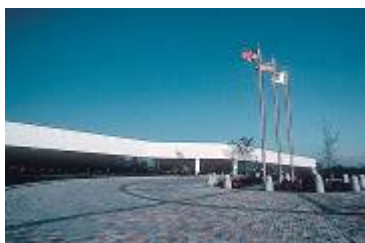
1986年に設立された北米初の生産拠点YMMC。ゴルフカーを皮切りに生産が始まり、現在ではアメリカを主要市場とする製品群がこの工場生産されている
