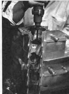
⑥そしてオイルシール孔の5カ所とその後部の2カ所に設けたタップおよび前部の流用の3カ所をネジ止めする。各部のシールは完備なものにすること、またボルトの頭がクランクウェブに当たらぬように配慮する。
