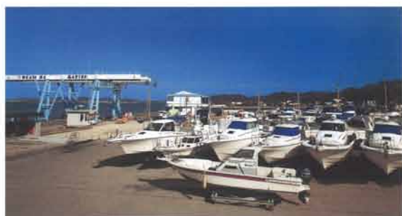
県内最大規模を誇る岡山マリン・宮浦マリーナ。シーズン中は3基のクレーンがフル稼働し、太公望の週末をサポートしている
