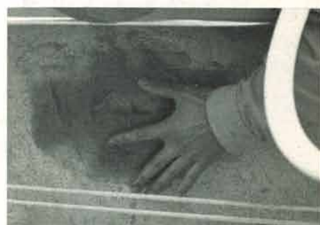
③破損箇所の裏側からマットを何枚も重ね合せて、最後にロービングクロスを貼り、指でしごいて気泡と、余分の樹脂を除く。
