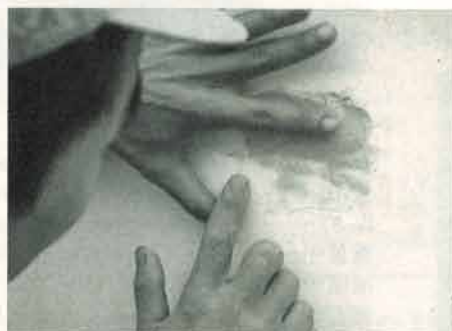
④表側からは破損のくぼみにペーストをうめ上にセロハンをかぶせて表面をきれいにととのえる。セロハンペーストを外気から断り硬化を促進させる働きもある。
