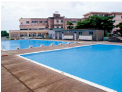
1978年設置（静岡県磐田市立東部小学校）
