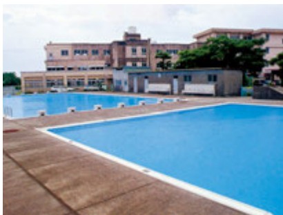
1978年設置 (静岡県磐田市立東部小学校)
