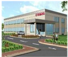
スラジプール工場 (部品加工・組立)
