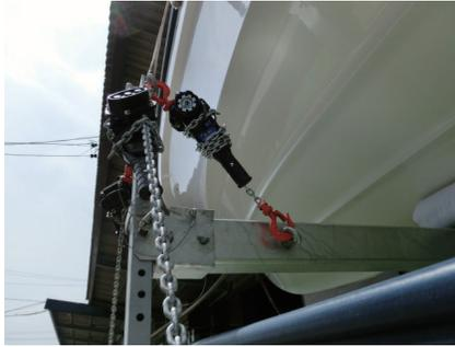
図 11 梁と柱の固定
