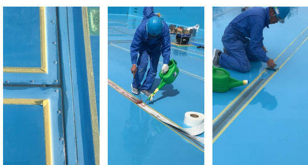
(a) リベット打ち (b) FRP 積層 (c) ペースト塗り
