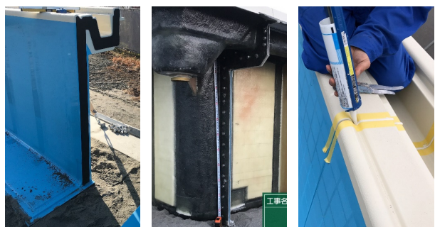
(a) パッキン貼り (b) ボルト締め (c) コーキング仕上
