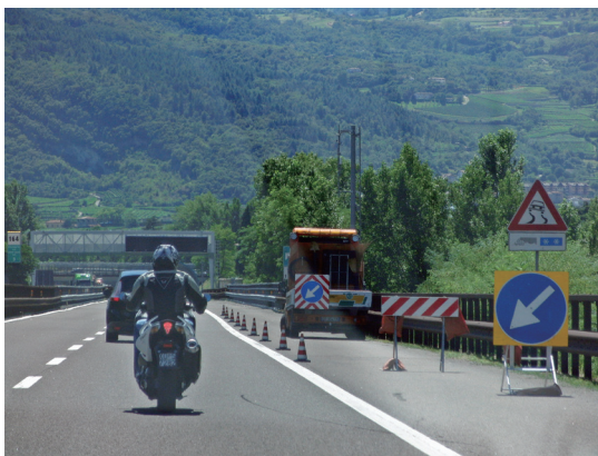
図6 道路工事通過の様子
