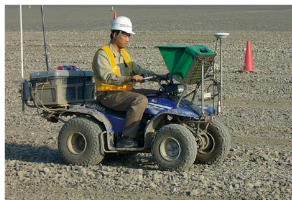
図1 有人での地盤高測量
