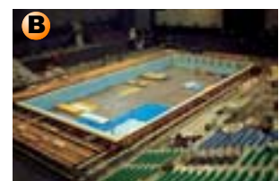
FRP 本体の組み立て
