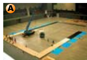
プレハブ基礎の搬入と設置
