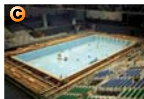
プールサイドの組み立て
