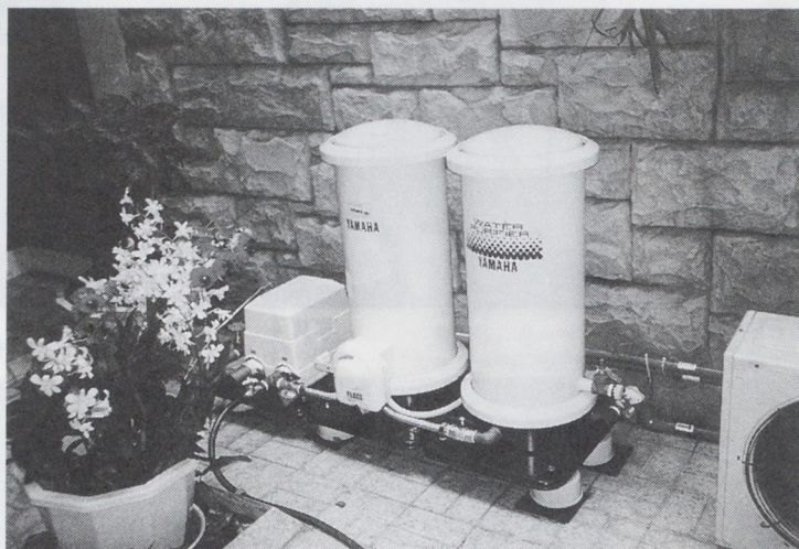
写真7 据付け終了後のOH300P
