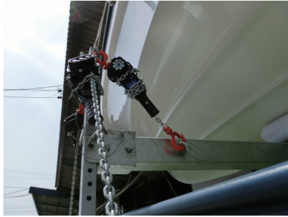
図 11 梁と柱の固定
