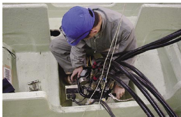
図20 ウレタン注入作業
