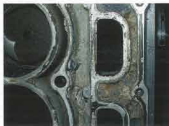
Without flushing (after approx. 500 hrs. use) Sans détartrage (après env. 500 h d'utilisation)
