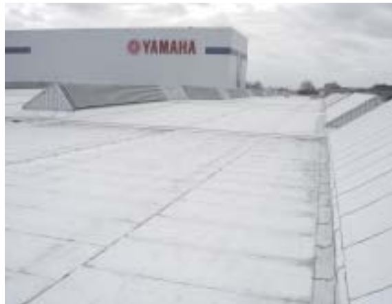
白く塗り替え改修した屋根
