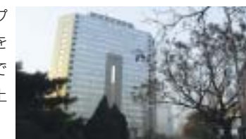
北京駐在事務所が入っている建物
