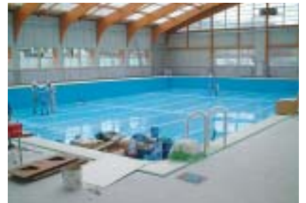
プール施工風景
