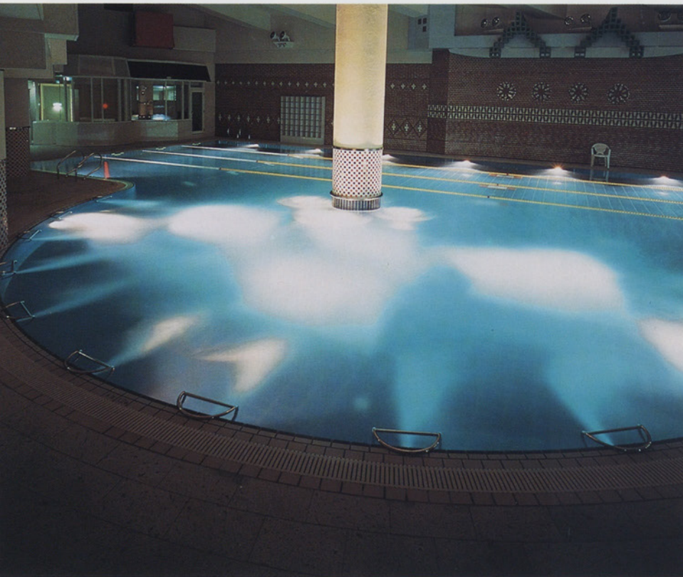
水中照明 室内照明における水面への乱反射を防ぎ、表情豊かな水中を演出し、水をより美しく見せるとともに安全性を高めます。
