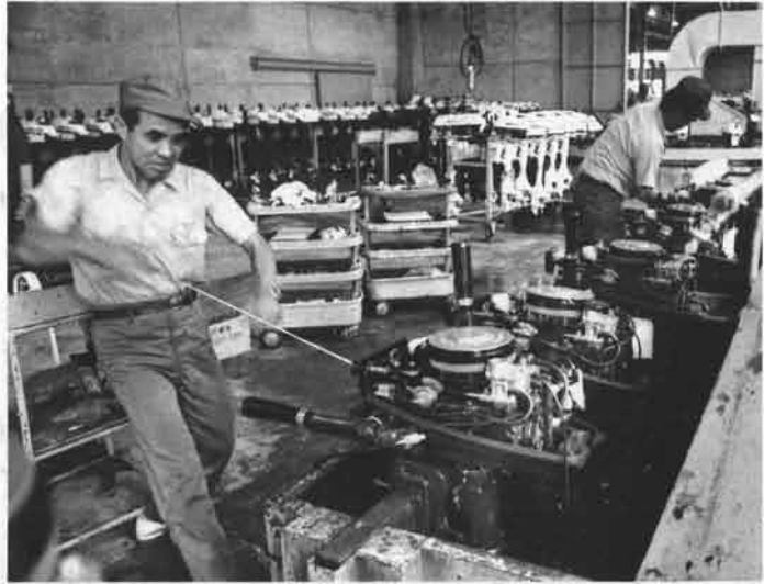
9 大排気量船外機のテストは、こちらの水槽で行なわれる。生ぶ声のようなエンジンとプロペラの轟音は、はやくもたくましさをみなぎらせている。
