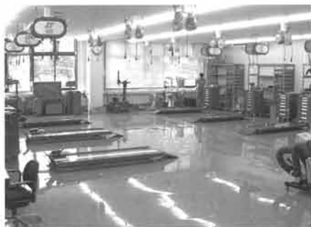
サービス工場は「床排気システム」「二輪検査ライン+エンジンパワーテスター」といった最新設備を充実させた
