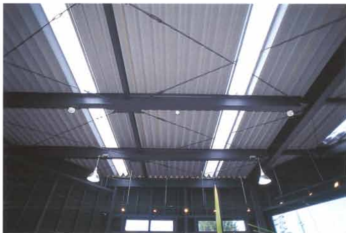
ロフト構造のショールームは、内装を黒にした分、大きな全面ガラスのウィンドーと屋根の一部を半透明の波板にして採光。さらに水銀灯とスポットライトで補助し、十分な明るさを演出している
