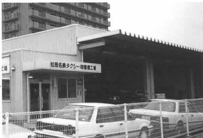
日ごろタクシー車両を整備している自社工場(指定整備工場)を使い、一般車の車検整備も請け負う。技術的な安心感に加え、朝出せば夕方には整備が終了するスピードと割安な料金体系が特長となっている
