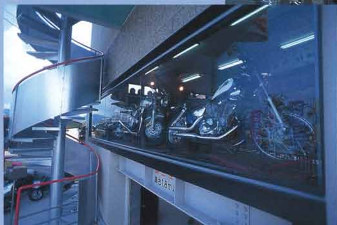
ショールームのウィンドウは設計時に苦慮した点の一つ。外観を考えた場合、小さな窓の方が見た目はいいのだが、もちろんバイクも見せたい。その結果、壁の下半分をガラス張りにする形が取られた
