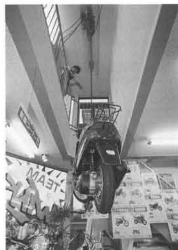
2階ショーウィンドーを飾る車両は、一部吹き抜けにした1階の天井からウィンチでつり上げる
