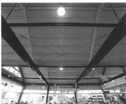
ちょっとした体育館ほどもある高さの天井は、照明のライトとじやまにならない程度のPOPがあるだけで、十分な解放感を確保している
