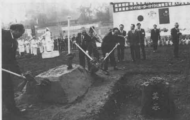
'94年6月の生産開始をめざし、社屋着工の礎を入れた
