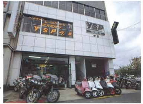
3階建ての2階までを改装して利用。オープンスペースも充分
