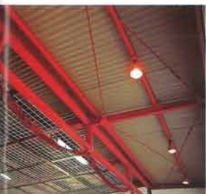
ショールームには蛍光灯とタングステンスポット、水銀灯スポットを利用
