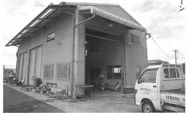
30フィートを収納する工場の前にはお客様のポートが多数置かれている。
