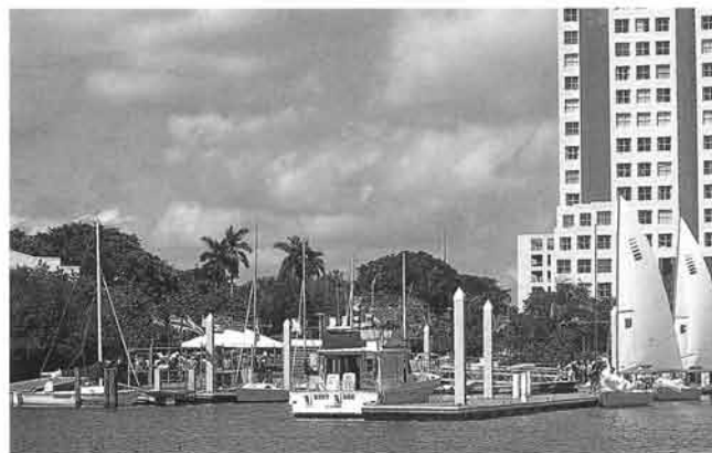
沖からのマリナー全景(背後のビルは別の施設)。左奥に新しいクラブハウスの建築が決まっている。2000年12月完成予定
